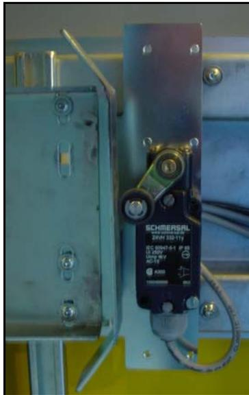
Mit dem Zwangskontaktschalter wird die Schachttür an jeder Haltestelle zum öffnen überwacht.
