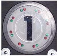
Mit der *Stockwerkstaste* wird der Fahrkorb in das gewünschte Stockwerk geschickt.
