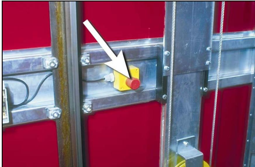
Im Fahrschacht ist für Instandhaltungsarbeiten ein Not-Aus-Taster angebracht.
