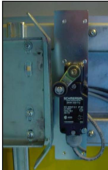
Hinter der Fahrkorbverkleidung des Güteraufzugs ist auf jedem Stockwerk ein Zwangskontaktschalter angebracht. Mit diesem Schalter wird die Schachttür zusätzlich überwacht damit sie nur zu öffnen geht wenn der Fahrkorb auch an der Haltestelle ist.
