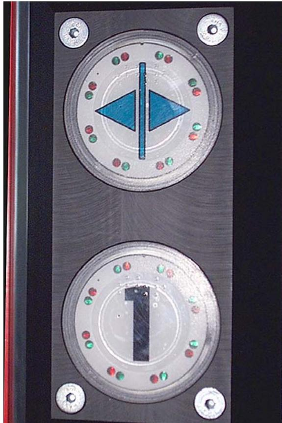
Die Bedienung des Güteraufzugs erfolgt über zwei unterschiedliche Taster: die *Anforderungs-/Türöffnungstaste*, die *Stockwerkstaste*.
