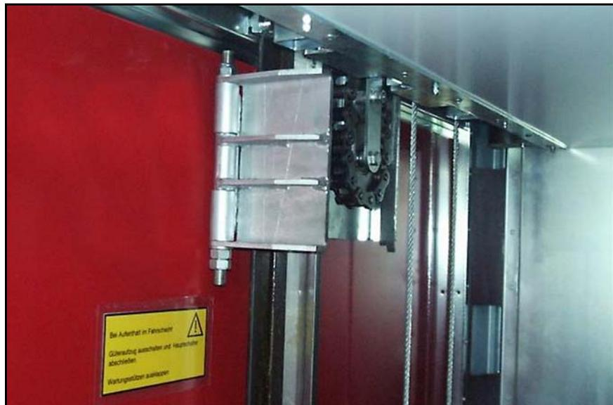
Die Wartungsstützen schützen das Personal bei Instandhaltungs- und Einstellarbeiten im Fahrschacht.
