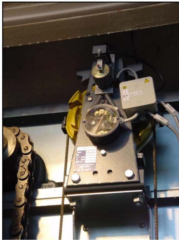
Der Geschwindigkeitsbegrenzer überwacht in der Abwärtsfahrt die Fahrkorbgeschwindigkeit. Mit dem Reglerseil wird die Fangvorrichtung ausgelöst, wenn die Auslösegeschwindigkeit erreicht wird. Der Fahrkorb wird dann zum Stillstand gebracht und an den Führungsschienen festgehalten. Durch die Absinkverhinderung wird durch einen zusätzlichen speziellen Mechanismus am Geschwindigkeitsbegrenzer eine ungewollte Abwärtsfahrt des Fahrkorbes verhindert.
